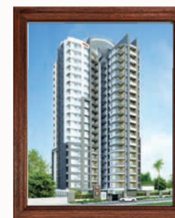
ZENITH Nellikunnu, Thrissur
